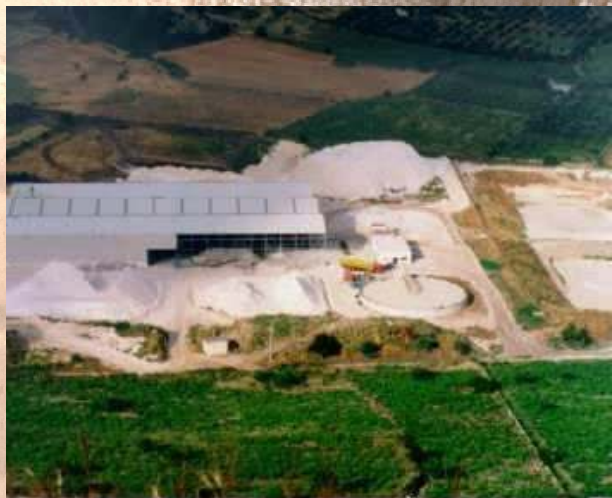
Stabilimento Di Florinas
